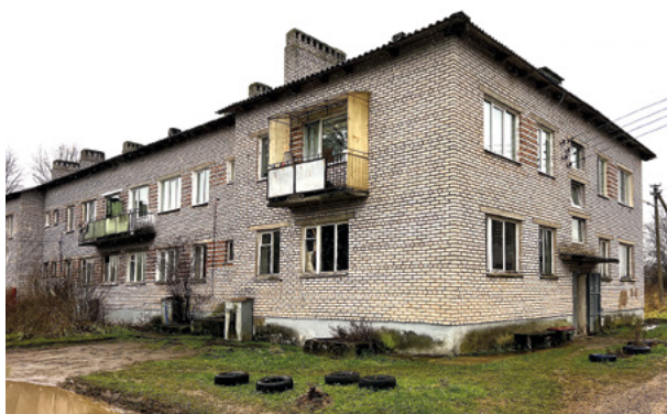
Многоквартирный дом в д. Черनावино
