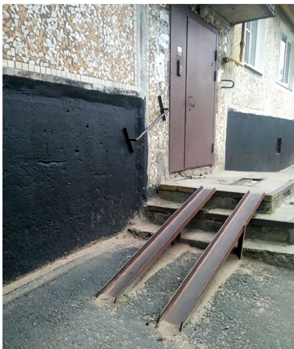
Пандус до ремонтных работ
