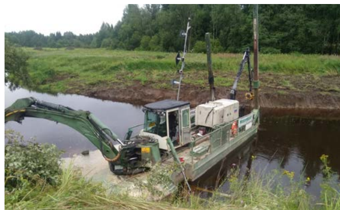
Процесс выполнения работ по расчистке р. Коваши
