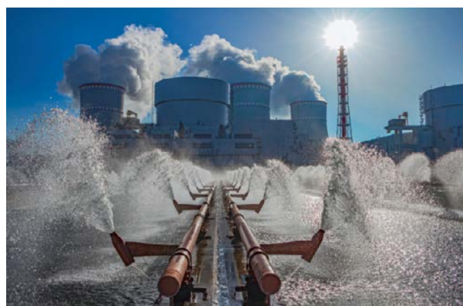
Новый энергоблок на ЛАЭС
