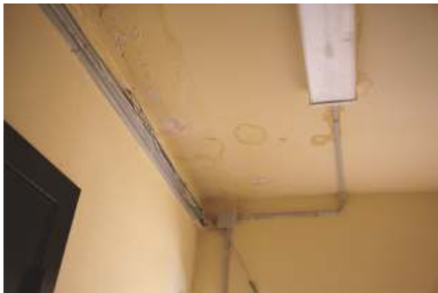
Следы протечек на потолке в квартире
