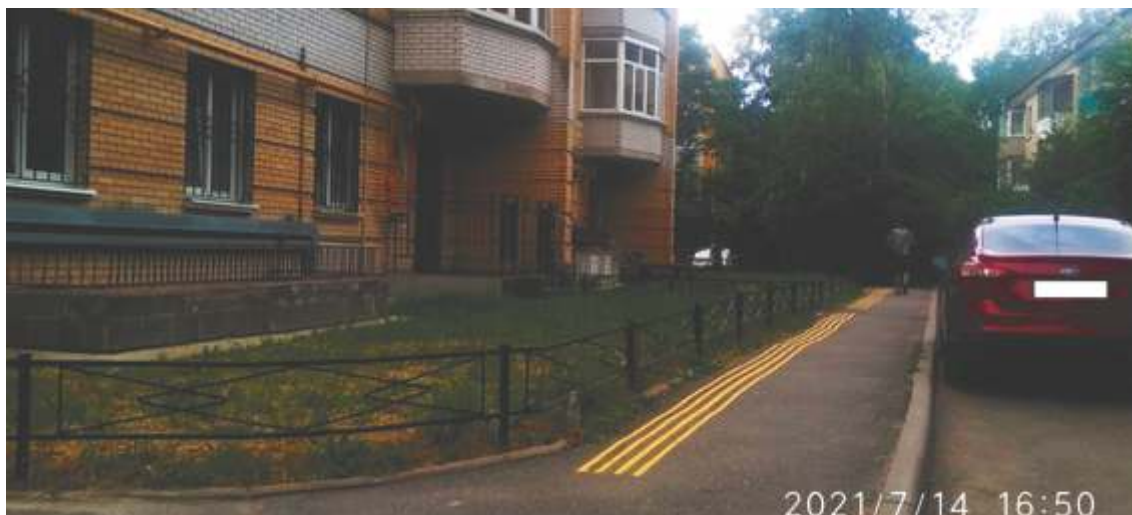
Высокий поребрик перед входом в ФСС
